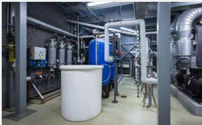
Para una dosificación precisa de esas cantidades se utilizan bombas dosificadoras que pueden ser accionadas directamente por volumen o bien mediante equipos de instrumentación y control de regulación.
