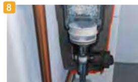
4 Abra la válvula de limpieza contracorriente; la cesta con las perlas sintéticas descenderá y cortará la entrada de agua. Retire el imán de la vaina.
