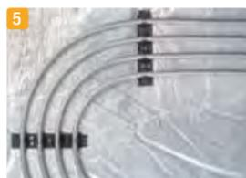
5 A continuación realizaremos la prueba de presión y dejaremos los tubos llenos de agua (si se esperan bajas temperaturas realizar el llenado de los circuitos con anticongelante).
