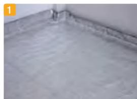
1 Sobre la superficie a calefactar, una vez limpia, colocaremos la lámina aislante elevándola en el perímetro de los locales por las paredes para que nos haga de banda perimetral.
