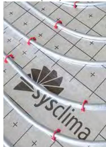
Instalación de suelo radiante con Sistema NP en Guardería de Valtierra (Navarra).
