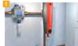
5 El filtro multifunción realiza la función de separador y purgador de aire y elimina los lodos y partículas férricas del agua de su sistema de calefacción / climatización.
