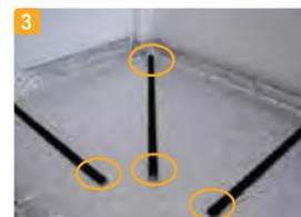
3 Es necesario fijar el conjunto del carril con unos clavos al forjado para evitar que con la fuerza de los tubos se pueda levantar toda la instalación.
