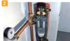
1 Limpieza de lodos: los lodos del circuito de calefacción / climatización quedan adheridos a unas pequeñas perlas sintéticas.
