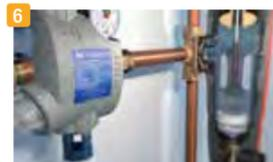
3 Separador de aire y purga permanente. El aire sube en el HF 3415, el flotador baja y abre la válvula para soltar el aire.
