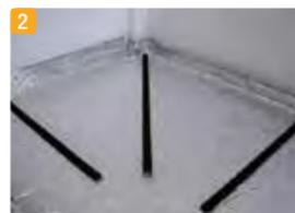
2 Seguido colocaremos el carril soporte de tubería en forma de espiga o cruz. Este carril dispone de una cinta autoadhesiva para su colocación.
