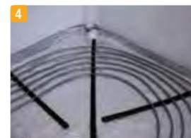
4 Una vez fijadas las guías, procederemos a la instalación del tubo que colocaremos con una separación entre ida y retorno de 10 cm.
